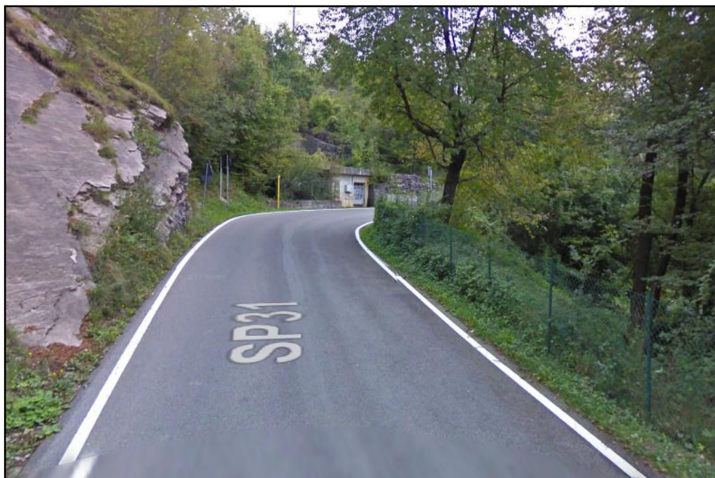
Figura 2 - Accesso al comune di Aviatico dal Comune di Costa Serina (da Google Street View)
